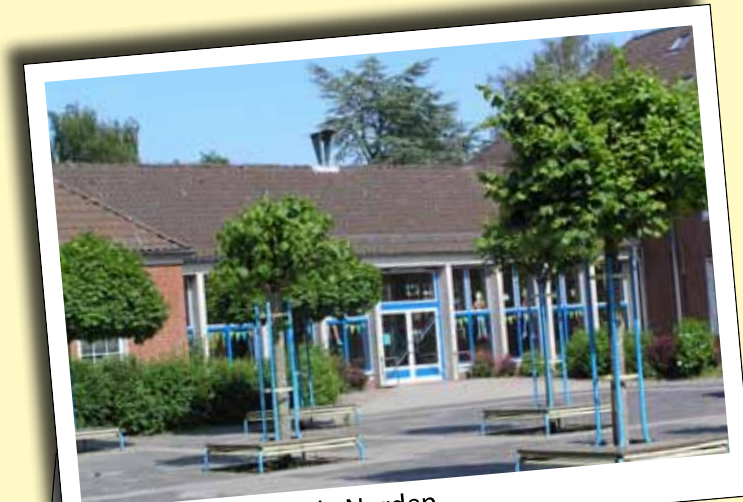
Linteler Grundschule Norden
